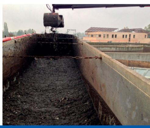
Aprotek, avec ses produits Apromud, vise à faciliter les opérations de curage et de nettoyage ou tout simplement à rendre pelletables les boues trop liquides, suite à des dysfonctionnements par exemple. Apromud peut être appliqué grâce à des équipements d'injection en ligne ou à l'aide de godets. Le dosage varie de 0,1 à 1 % du poids de boues.
